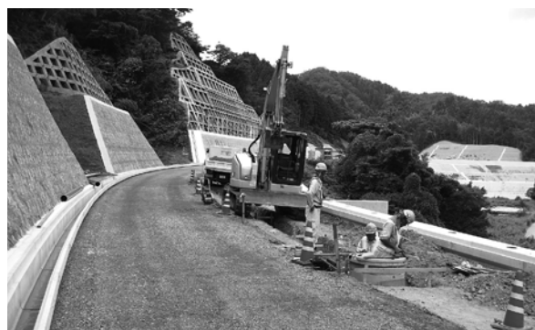
▲地下埋設管布設工事
