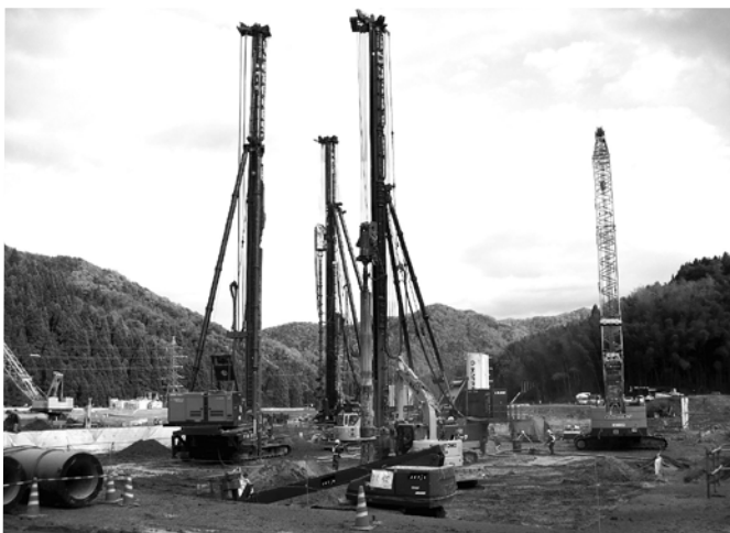
▲基礎杭の打設状況
