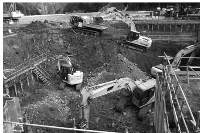
▲ごみピット部の掘削状況
