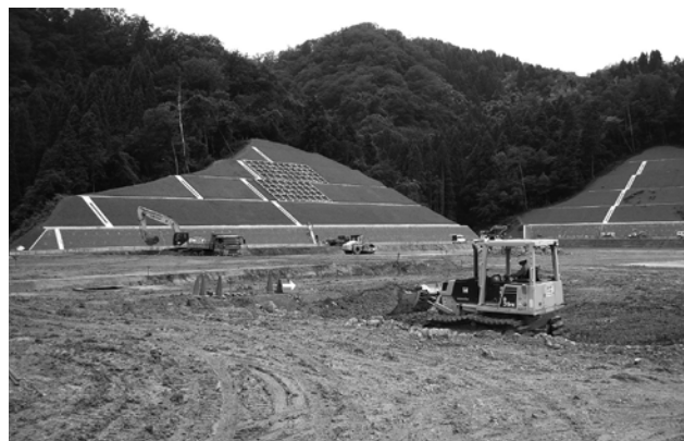
▲進入道路・敷地造成工事
