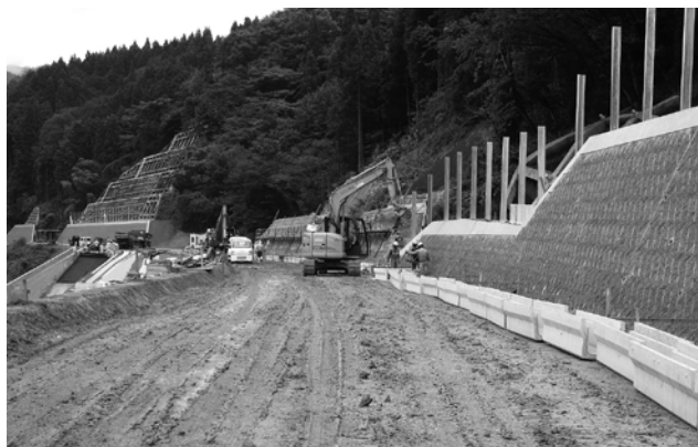
▲進入道路・敷地造成工事
